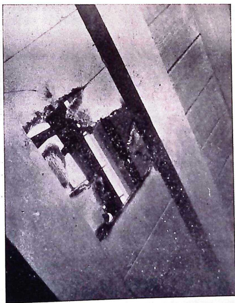
Detta är undersidan av samma golv. Bilden visar tydligt hur Porcellamålningen förhindrat eldens utbredning.
